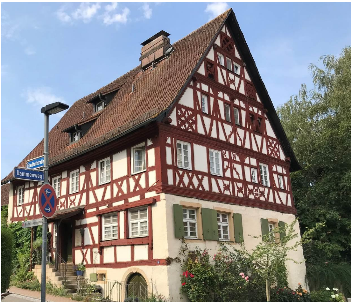
Fachwerkhaus Ecke Friedhofstraße / Dammenweg mit Sockelbereich
