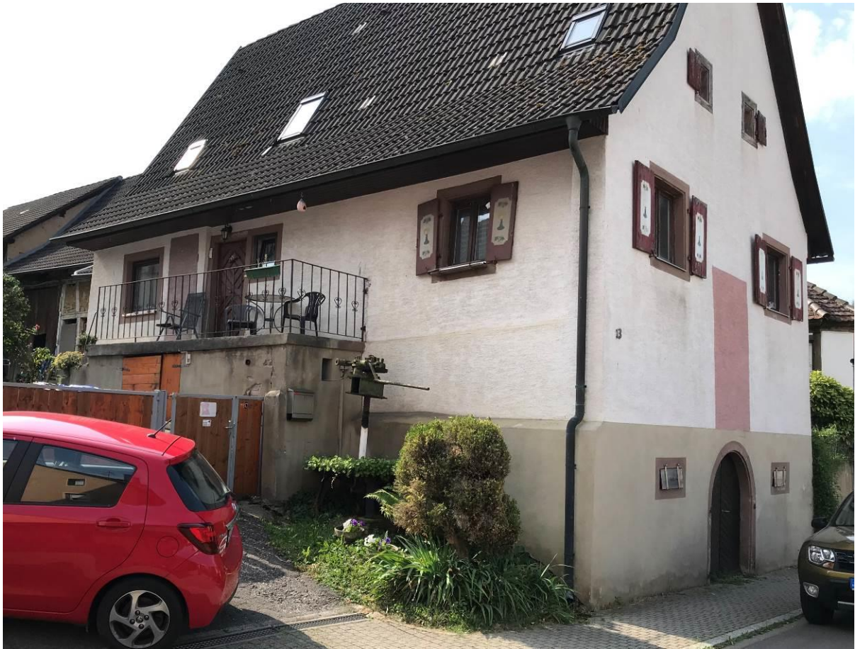
Giebelständiges Gebäude Talhauser Straße mit Sockelbereich
