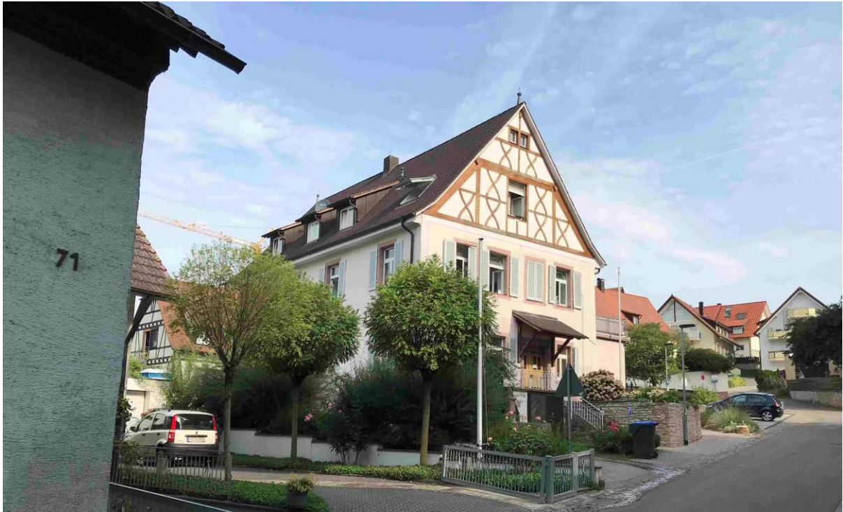
Fachwerkhaus Schönbergstraße 73 - Katholisches Pfarramt
