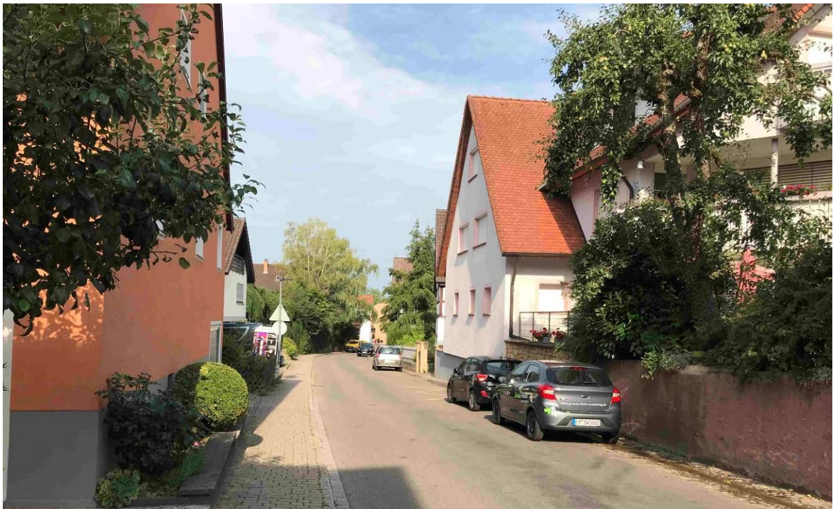
Giebelständige Gebäude Schönbergstraße 66 - Blick Richtung Westen
