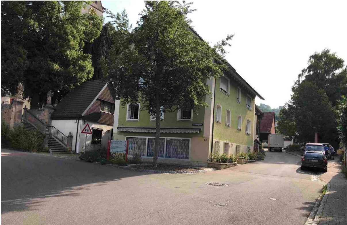
Ecksituation Schönbergstraße / Friedhofstraße mit Sockelbereich
