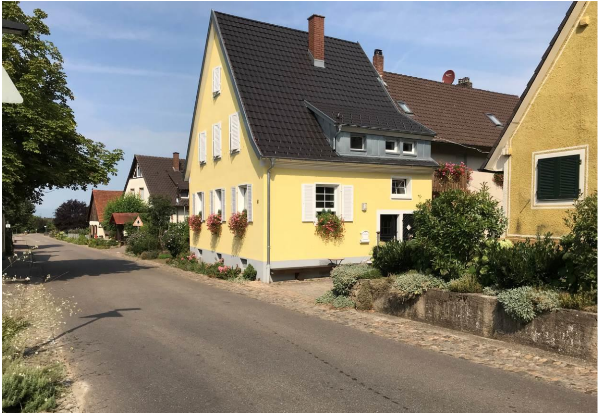
Giebelständiges Haus Schönbergstraße 23
